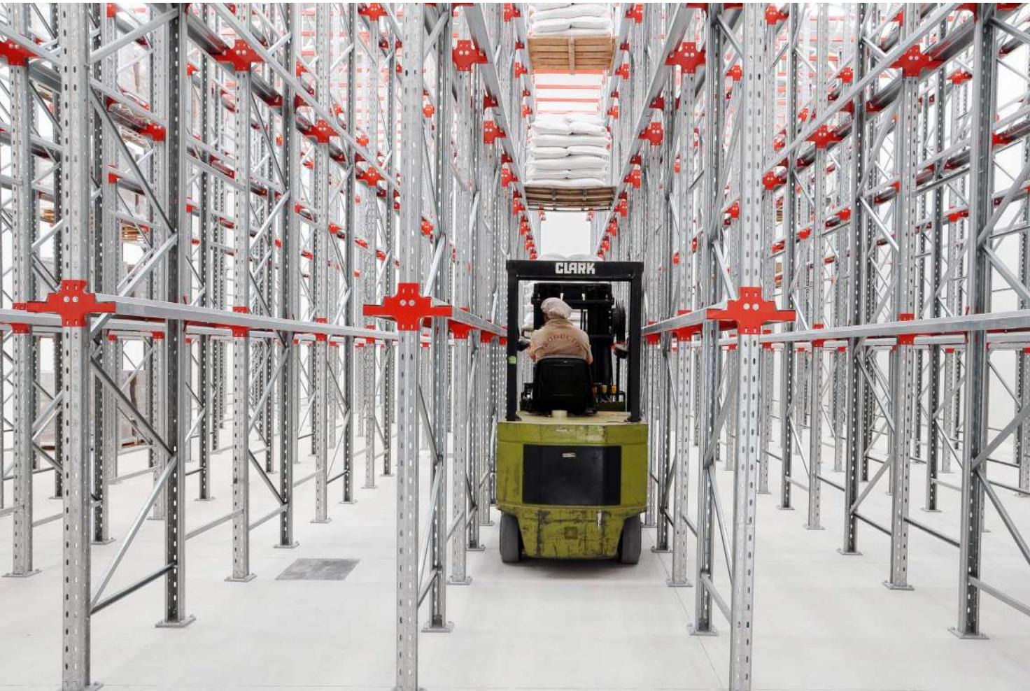
Fabricación e instalación de sistemas de almacenamiento y estanterías para carga ligera con una estructura ajustable y versátil para la distribución de los racks con base en el espacio disponible, altura del almacén y tipo de montacargas a utilizar para aumentar la capacidad de almacenamiento.
