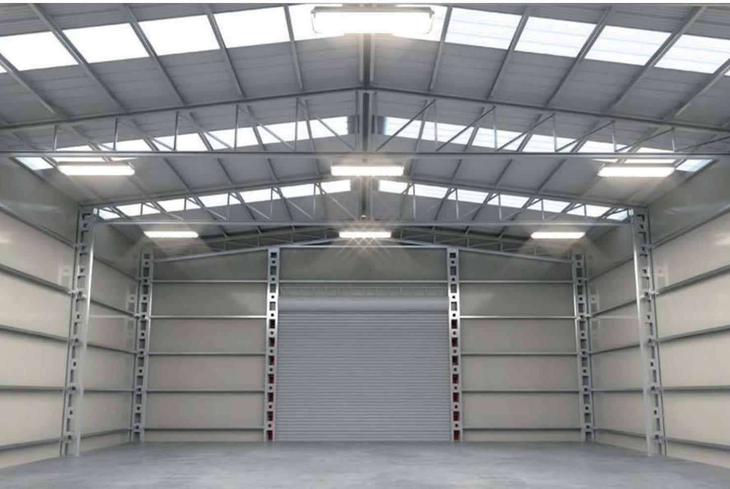
El sistema de estructuras ligeras de nueva generación Intramet® es un nuevo concepto de edificación prefabricada, a base de elementos ligeros de rápido ensamble y listos para ser recubiertos con una amplia variedad de materiales para generar espacios de usos múltiples y de gran rentabilidad.
